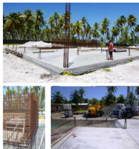
Chantier du CIS de Ohotu – Rangiroa, figurant parmi les toutes premières opérations de travaux programmées en 2021 et dont la livraison est prévue fin 2024. (Source : DIP / nov 2023)
