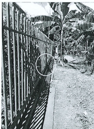
Photo 2 : Conduite d'arrosage, côté montagne
